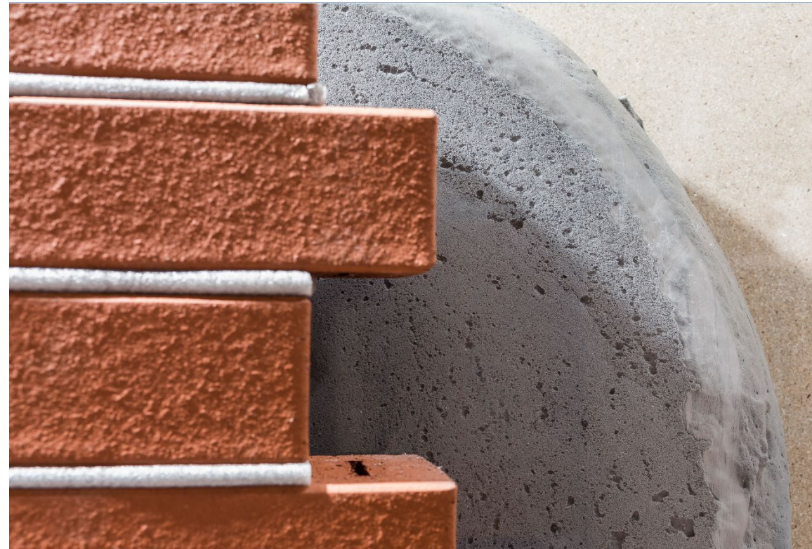
Cavipor Schaum in einer Modellwand
